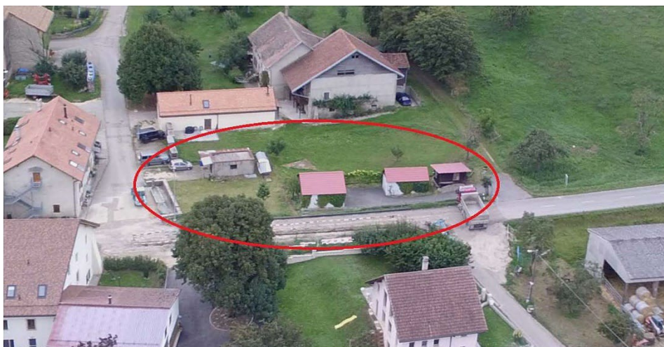
Figure 3 : Vue par drone des parcelles 121 et 120
