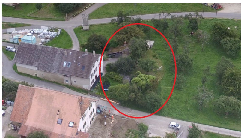
Figure 6 : Aménagements extérieurs devant le bâtiment n°17
